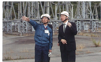
東京電力新福島変電所緊急視察(富岡町) 10月24日
