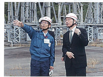
東京電力新福島変電所緊急視察(富岡町) 平成26年10月23日
