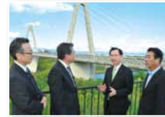
③内灘レインボーブリッジを視察(内灘町) 10月6日
